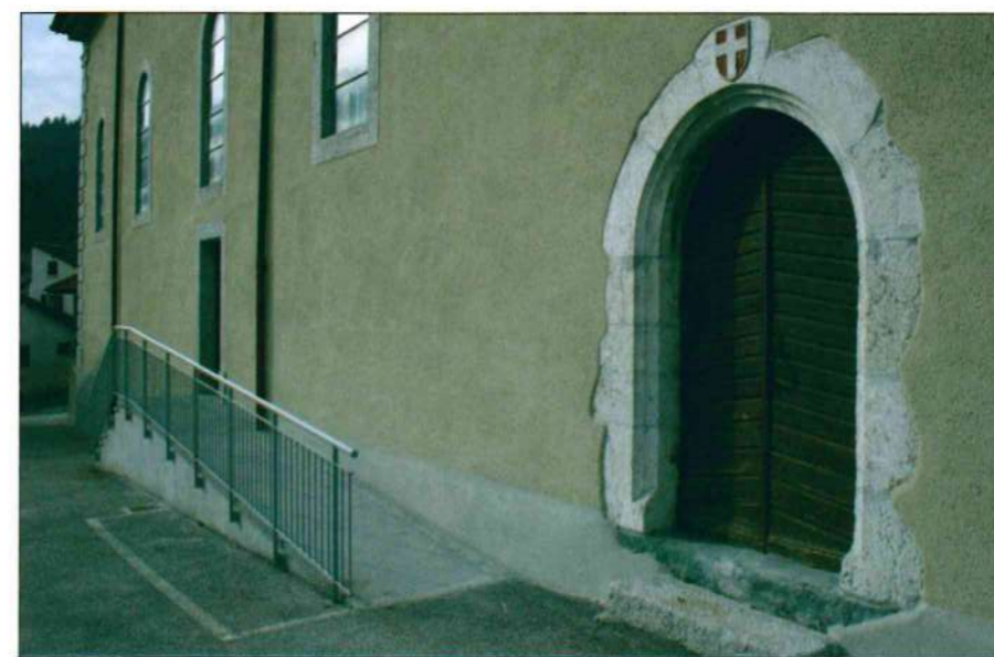
Rampe d'accès handicapés
