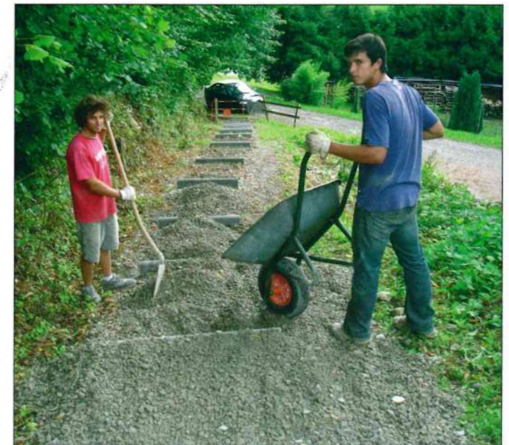
Aménagement du chemin reliant la route des Devants au Groupe Scolaire.
