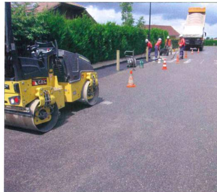
Goudronnage trottoirs Route des Bois
