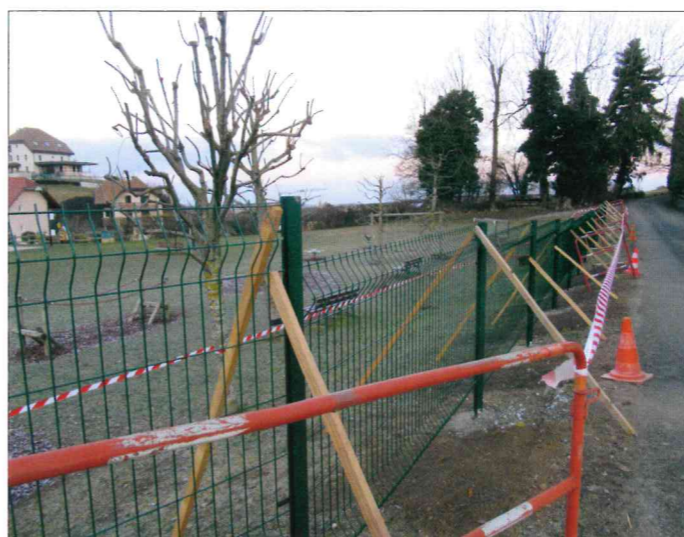
Pose d'une clôture rigide à proximité du Champ Dunant par les employés du SIVOM pour la sécurité des enfants.
