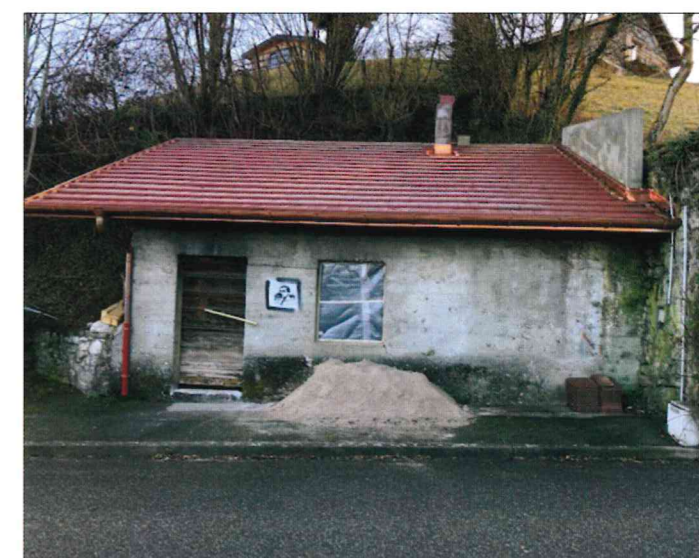
Suite de la réhabilitation du four par les bénévoles.
