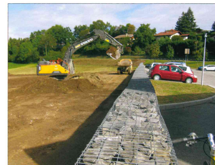
Début du chantier de la résidence "Autonomie" pour personnes âgées valides.
