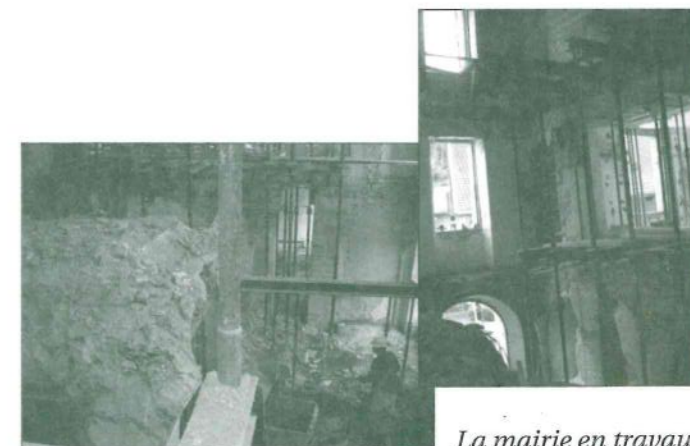
La mairie en travaux
