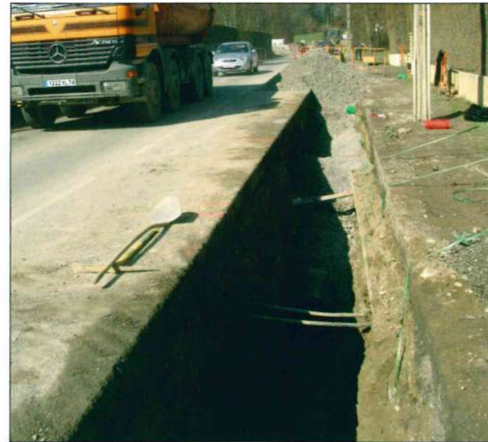
Tranchée pour les eaux pluviales.
