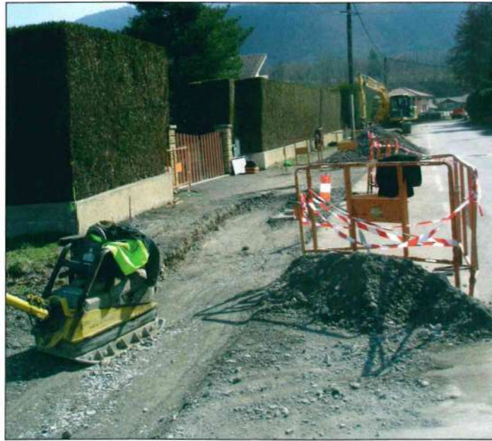
Préparation de la pose des bordures.
