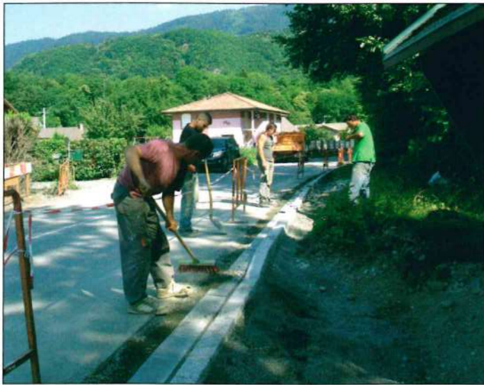
Pose des bordures du trottoir.
