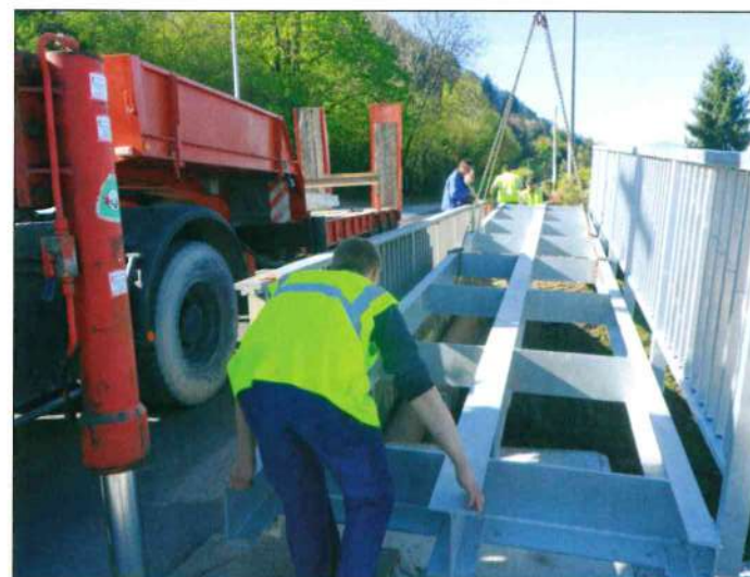
Installation de la passerelle route d'Orcier
