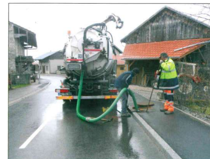
Nettoyage des grilles d'eaux pluviales
