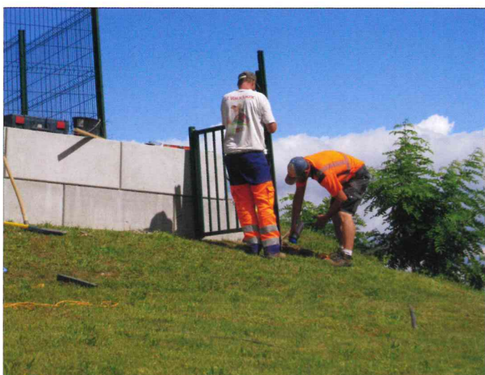
Sécurisation des abords de la mairie
