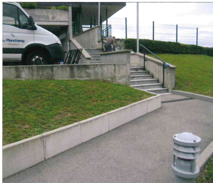
Remplacement de la main courante
