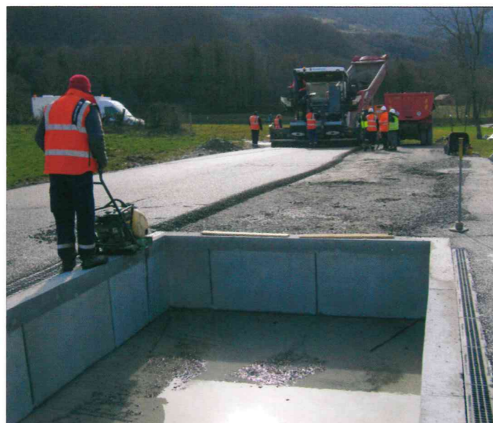
Goudronnage de la route de la carrière
