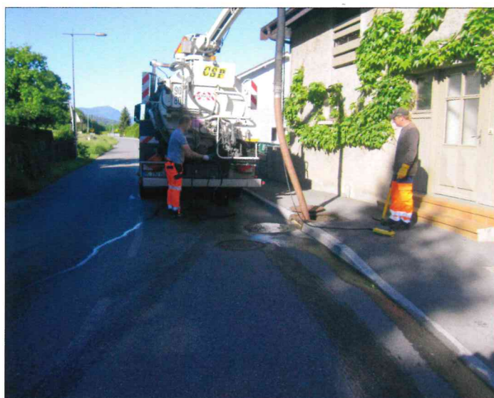
Curage des grilles d'eau pluviale
