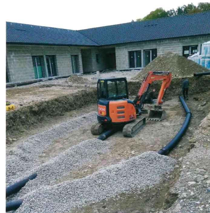
Aménagement de la voirie de la maison d'autonomie
