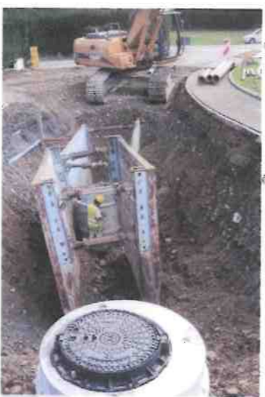
Chantier route des Bois
