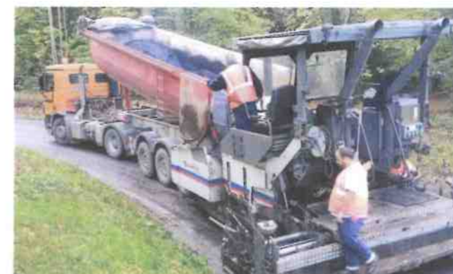
Réfection route des Chambrettes
