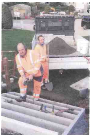
Modification des escaliers au Champ Dunant
