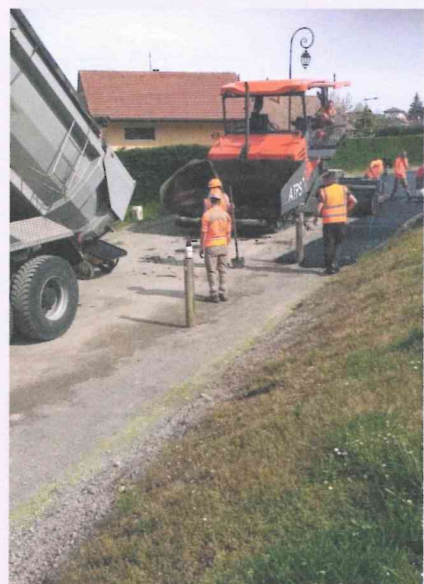
Enrobé route des Voigères
