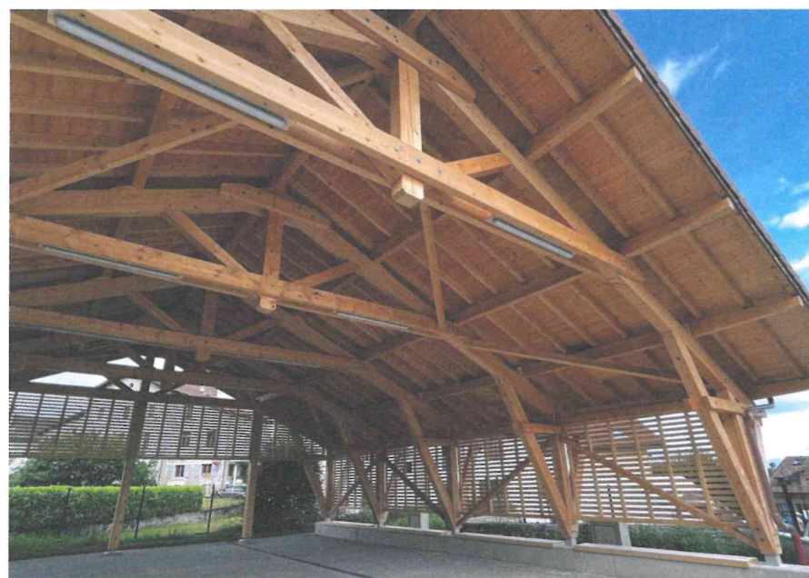
Achèvement des travaux de la Halle
