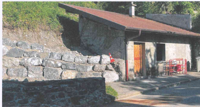
Création d'un enrochement
