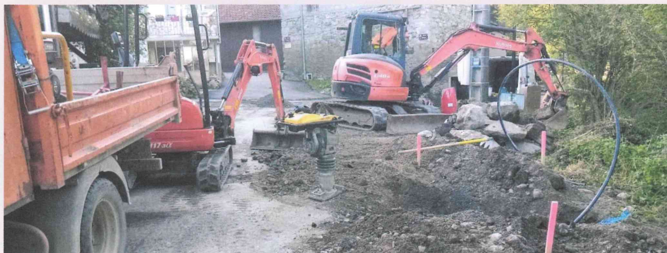
Enfouissement des réseaux - Route des Cathelins
