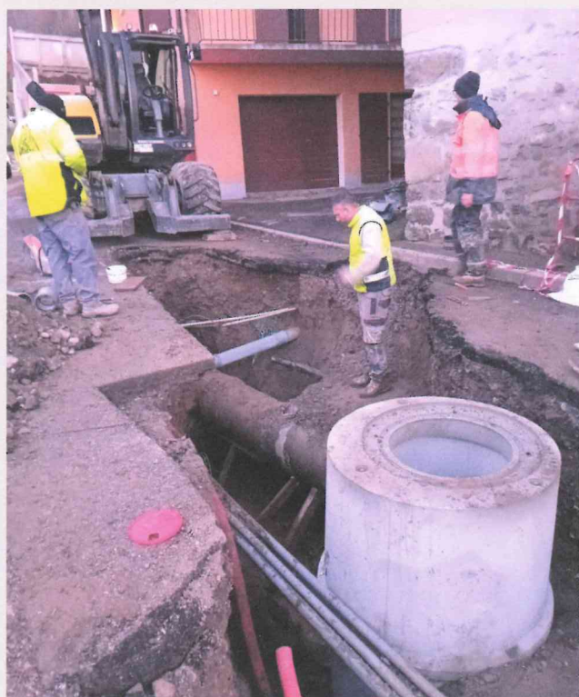
Séparation des eaux d'égouts et pluviales Rue du Quart d'Avaux
