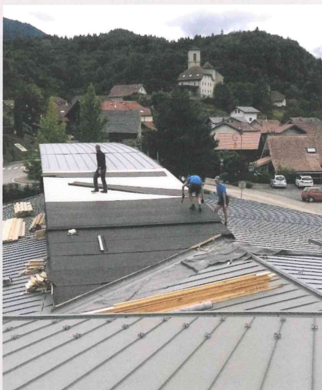
Réfection partielle du toit du groupe scolaire
