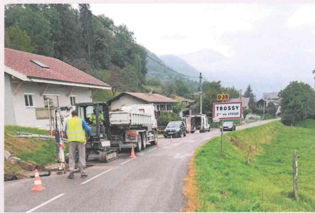
Enfouissement des réseaux à Trossy
