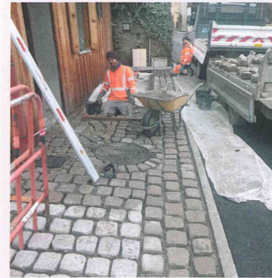
Pavage des abords du four et du pressoir
